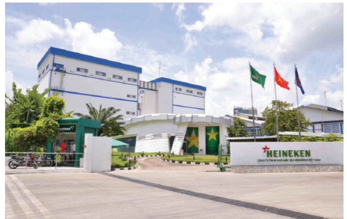
Nhà máy bia Heineken
